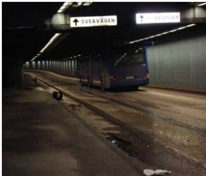
Figur 4. Bussen som stannat en bit in i tunneln den 16 december. Foto: Brandförsvaret
