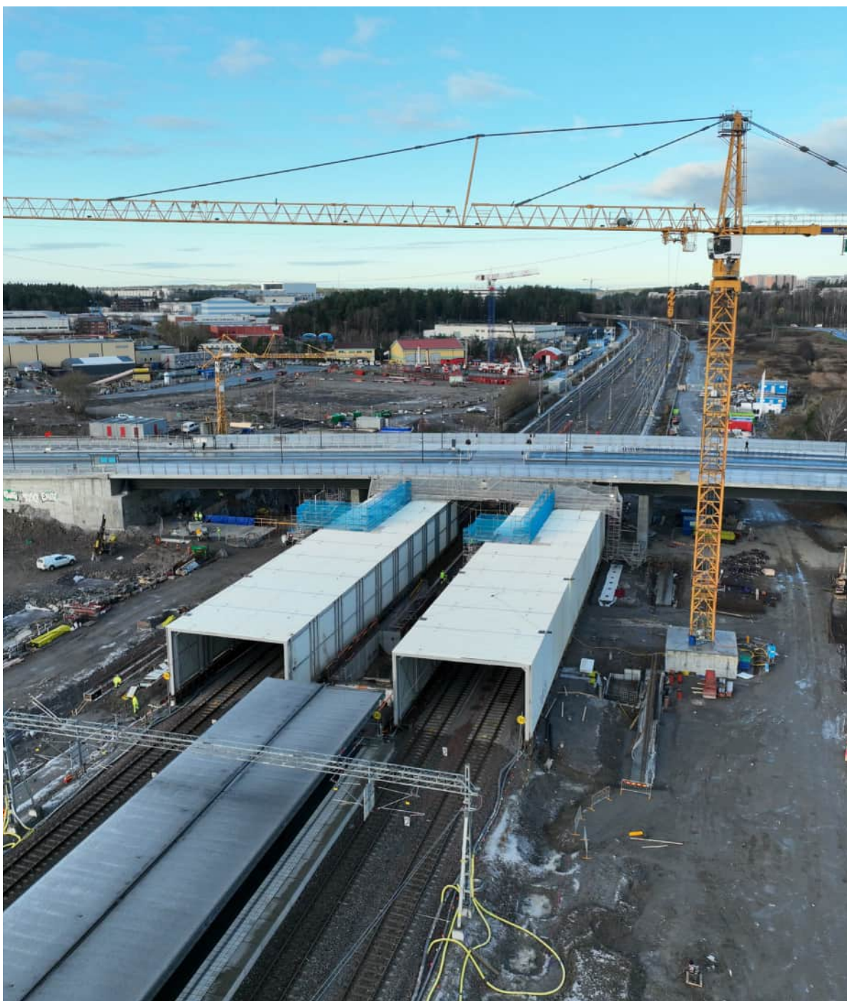
Mälarbanan, Barkarby. Foto: Trafikverket.
