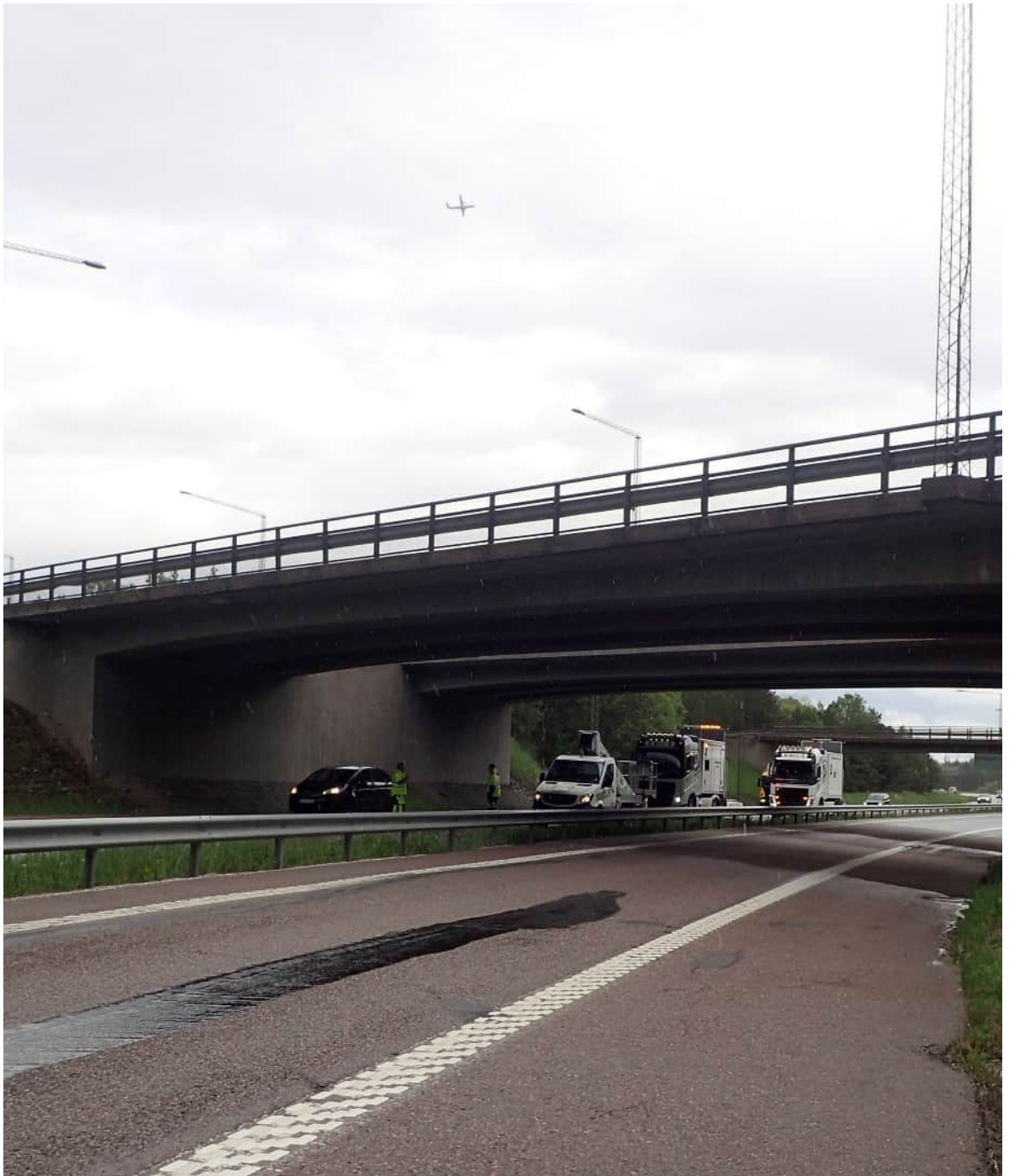
Trafikplats Arlanda. Foto: Trafikverket.
