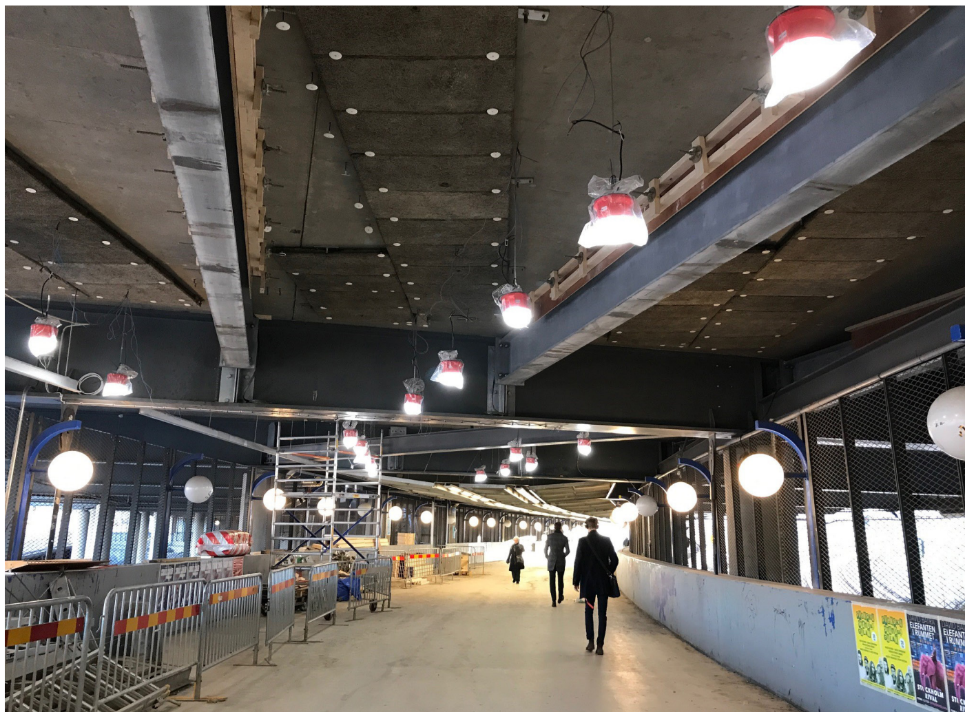
Förstärkningsarbeten i Arenagången mellan Gullmarsplan och Globenområdet. Foto: Region Stockholm
