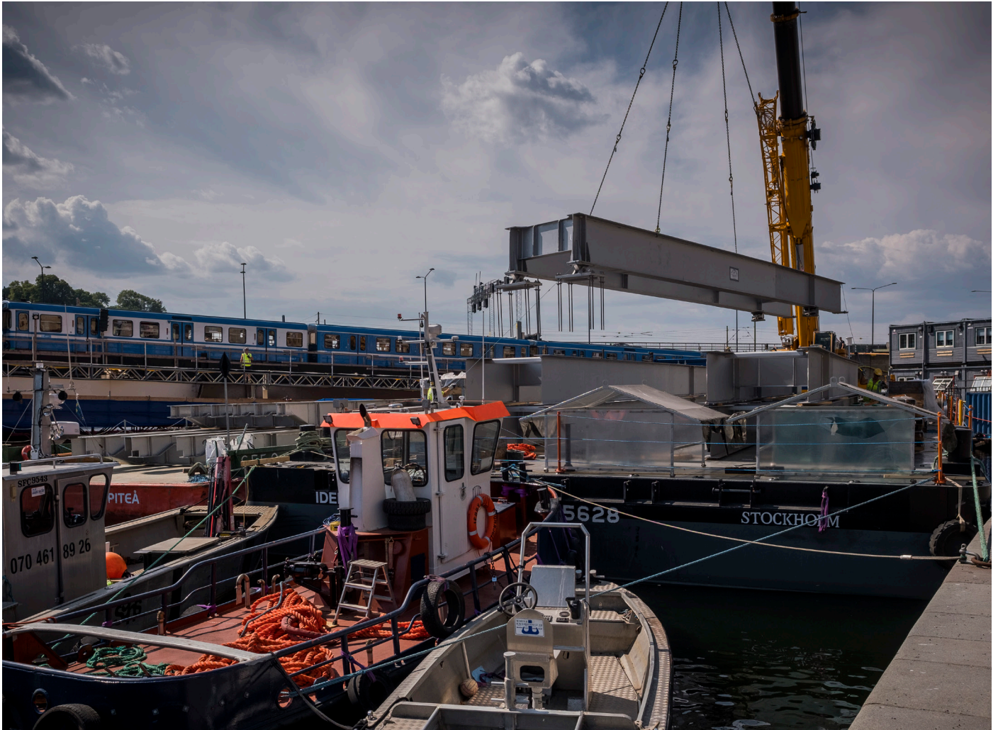
Bild från arbetet med upprustningen av Söderströmsbron. Foto: Gustav Kaiser/SL
