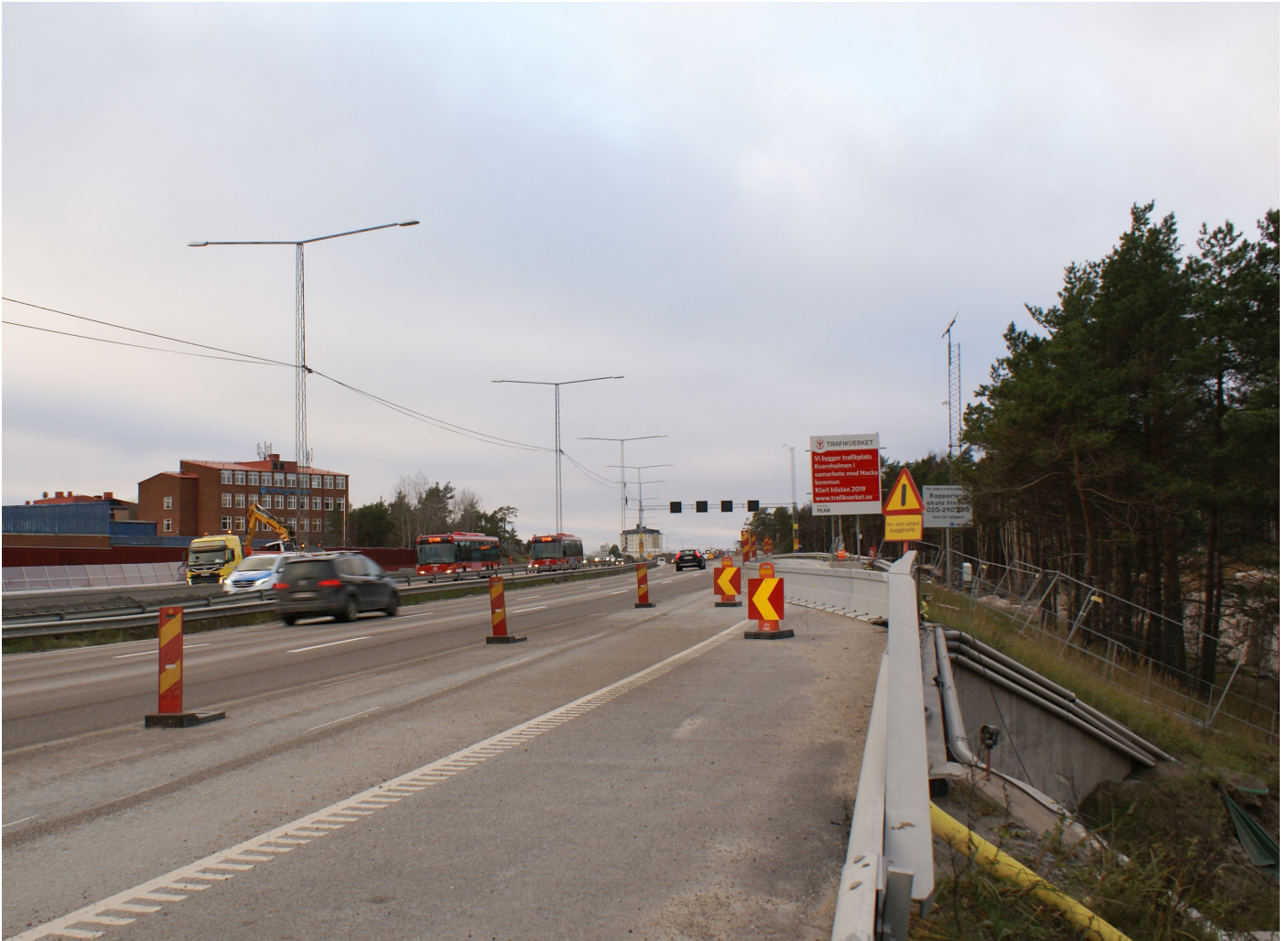
Trafikplats Kvarnholmen. Foto: Trafikverket
