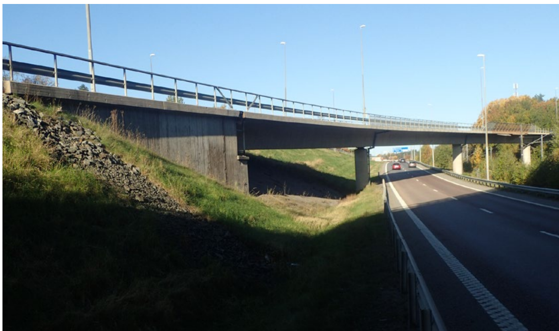
Trafikplats Trångsund. Foto:Trafikverket.
