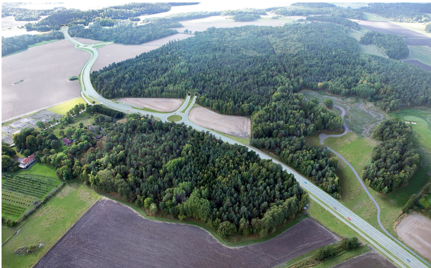
Illustration av delar av den färdiga Ekerövägen. Illustration: Trafikverket
