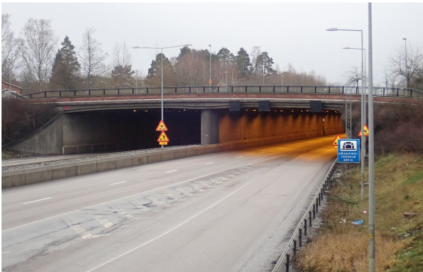
Häggvikstunneln. Foto: Trafikverket
