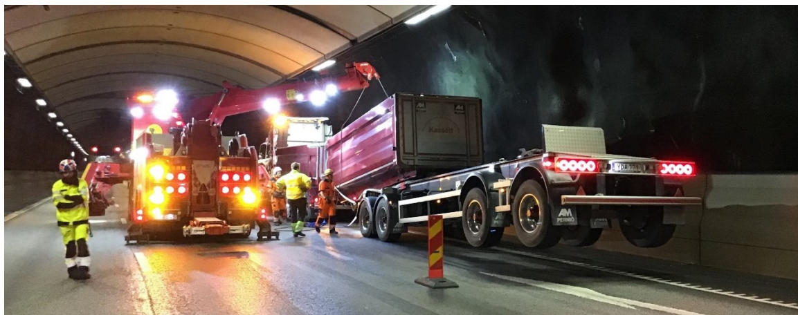
Figur 3. Bärning av det havererade lastbilen. Foto: Pelle Tumlare, VägAssistans
