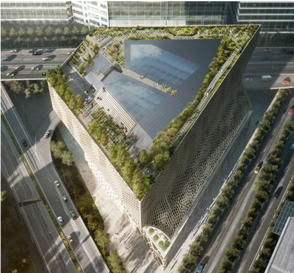
Samverkanscentralen med sin takpark som kommer att vara öppen för allmänheten.
