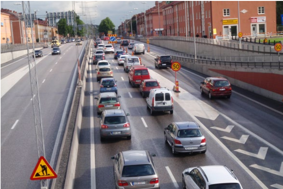
Bara ett körfält på Nynäsvägen fram mot bullerplanksbygget. Massiv kö i två körfält fram mot skyltvagnen. Samtidigt ingen kö alls från Södra länken.
