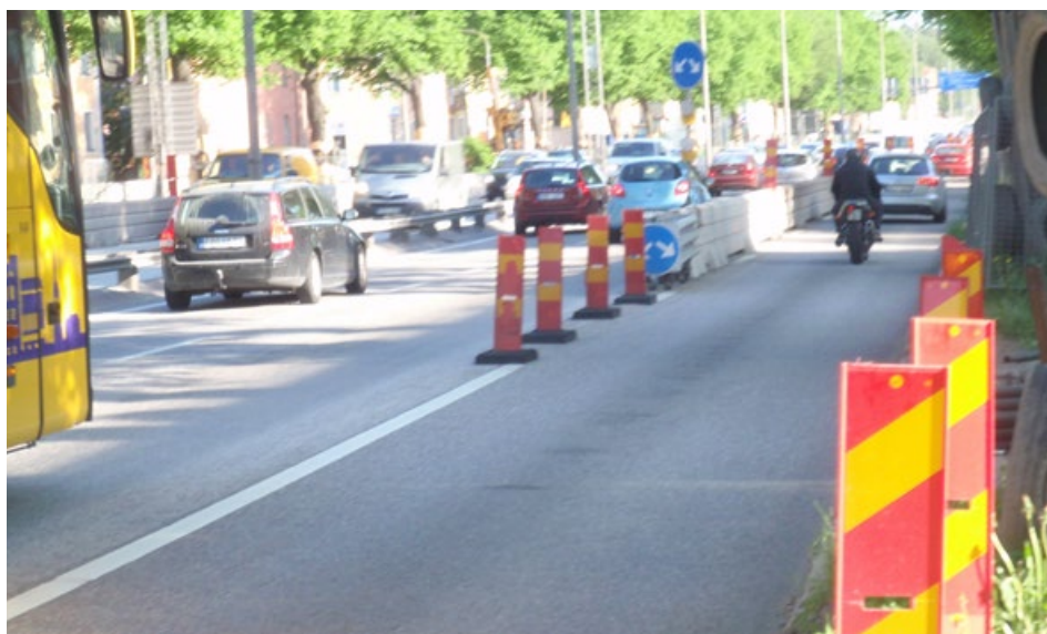
Den betongbarriär mellan höger och övriga körfält som kördes på ett antal gånger. Här med förstärkt utmärkning.
