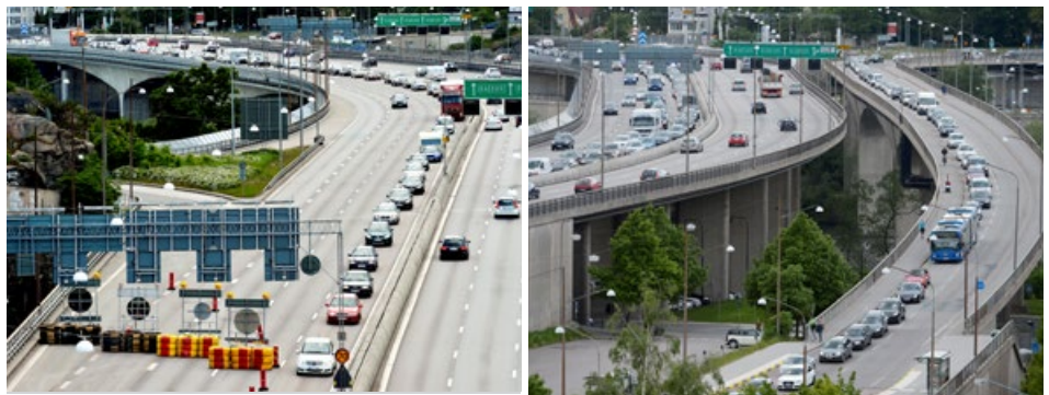
Till vänster: Köer fram mot den trasiga broskarven söndagen den 10/6. (En av helgerna mellan broskadan och sommarens arbeten). Endast ett körfält var öppet. Observera ködisciplinen till vänster och köerna på Gamla Essinge brogata till höger. Bland andra var stombusslinje 1 drabbad.
