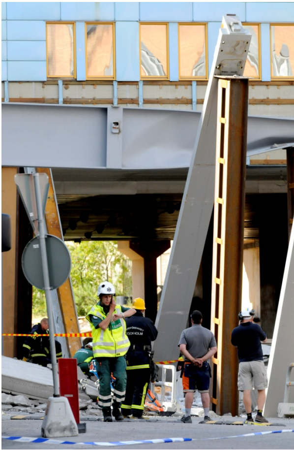
Foto: Ett bjälklag över Hanstavägen ger vika den 16/7.
