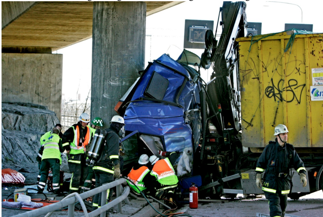
Foto: En lastbil kör på bropelare på E 4/E 20 Essingeleden vid Pampaslänken den 23/4.
