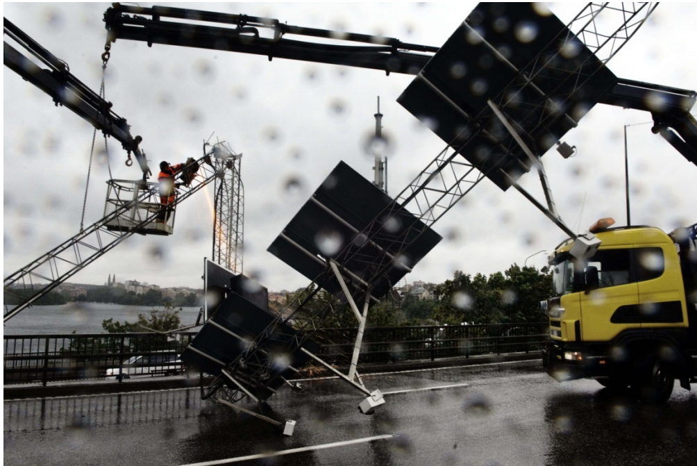
Foto: Portal nedkörd på E 4/E 20 Essingeleden vid Stora Essingen den 5/8.
